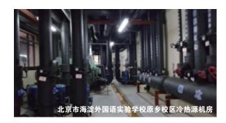
艺术学院、剧场、教职工食堂、学生公寓、教师公寓、室内运动场馆(综合体育中心、乒羽中心、冰雪运动中心、游泳馆、网球馆等)。采用恒有源分布式冷热源系统,一期共设置 4 个冷热源机房,二期设置 3 个冷热源机房,满足了全部供暖、制冷及全年生活热水的需求,实现了使用区域清洁能源无燃烧全覆盖,降低系统运行成本的同时,保护了生态环境。
