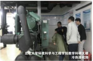
北京大学环境科学与工程学院的教学科研大楼坐落于北京大学主校区的东北部成府园内,占地面积 6521 平方米,为地上五层、地下三层,总建筑面积 20500 平方米。地源热泵系统包括 6 套(4 用 2 备)恒有源 350kW 单井循环换热地能采集井、2 台 YSSR-600B/2 地源热泵螺杆机组、13 台 DNV-I-280A/W 地能热宝多联机机组。其中地源热泵螺杆机组为楼内办公区域房间供冷/暖保持恒温。多联机机组常年为楼内实验室房间供冷/暖保持恒温。
