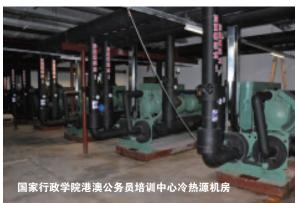
国家行政学院港澳公务员培训中心项目位于 北京市海淀区,总建筑面积为 43000 ㎡,包含涉 外培训楼、综合体育馆(游泳馆、网球馆、羽毛 球馆及乒乓球馆等)等建筑。要求满足冬季供暖、 夏季制冷、常年热水和泳池加热需求。项目原采 用传统的燃气锅炉和电制冷系统作为冷热源,运 行能耗高、污染大。
